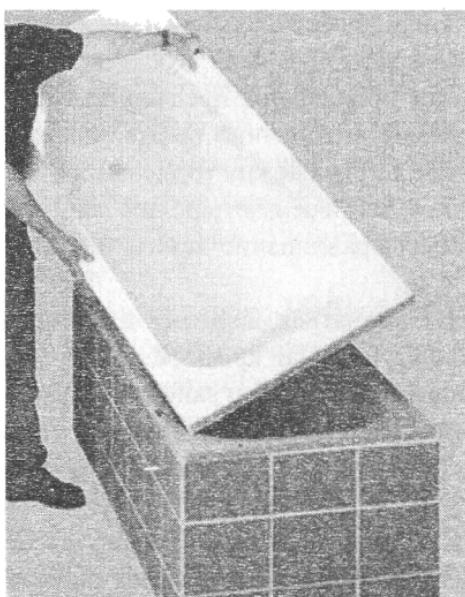
Процесс установки акриловой либо пластиковой ванны практически не отличается от установки ванны стальной. Главное отличие состоит в том, что на большинстве моделей опоры крепят не на самоклейку либо болты, а прикручивают непосредственно к дну ванны шурупами.
