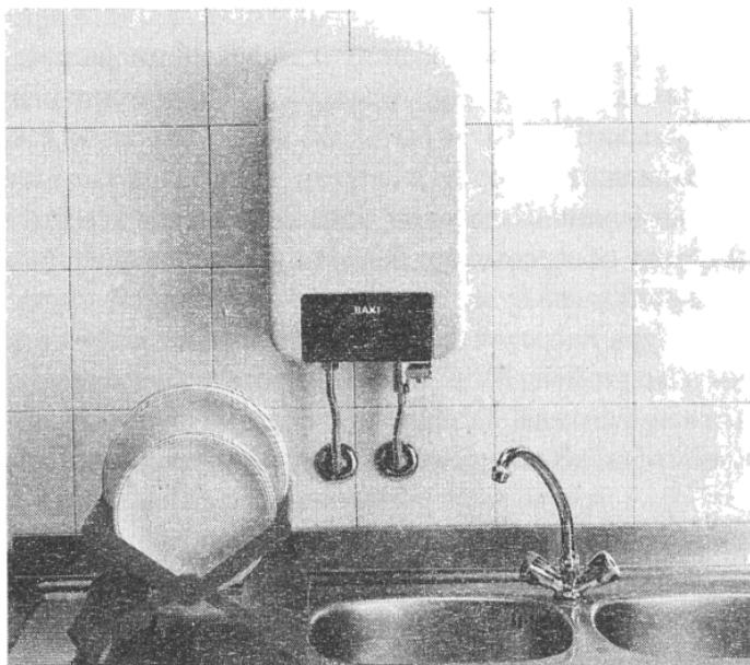
Данный прибор чаще всего устанавливают в помещениях, где уже расположены электроплиты, иначе для установки такого водонагревателя может не хватить электрической мощности проводки. Если в квартире стоит газовая плита, то здесь можно устанавливать водонагреватель электрический проточный только небольшой мощности.
