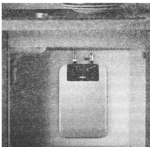
Настенный водонагреватель небольших размеров можно установить под раковиной. Проконтролируйте IP (уровень электрической безопасности приборов). Международный класс защиты IP выражается двумя цифрами:
