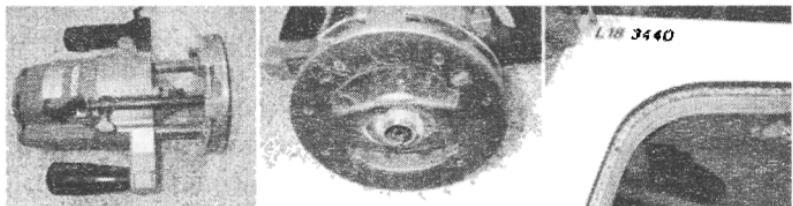
Чтобы установить интегрированную мойку, вначале выполняют черновой вырез (выполняется так же, как вырез для мойки врезной).
