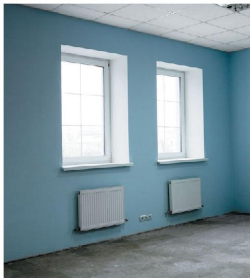
**Рис. 12.50.** Радиатор, установленный под окном, теряет 3–4 % тепла
