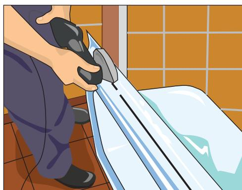
Рис. 11.92. Подрезаем борта вкладыша
