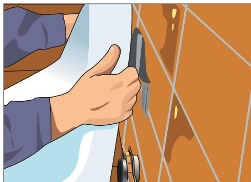
**Рис. 10.136.** Закрепляем писсуар на стене с помощью дюбелей
