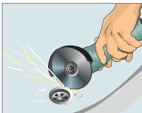
**Рис. 10.157.** Выпиливаем сливное отверстие с помощью ножовки или болгарки
