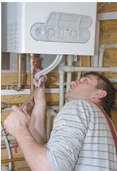
**Рис. 10.288.** Подключение нагревателя к водопроводу
