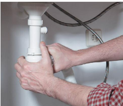
Рис. 10.78. Соединяем сифон со сливной трубой
