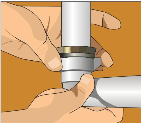
Рис. 11.52. Отсоединяем сифон
