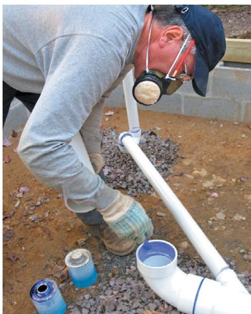
Рис. 4.64. Склейивание труб пластикового водопровода:
