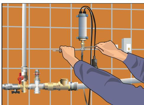
Рис. 4.27. Подсоединяя подводку к прибору с помощью гаечных ключей
