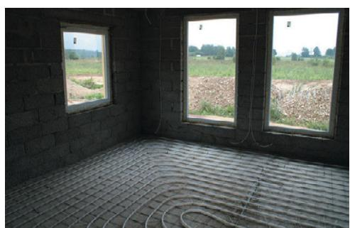
Рис. 12.2. Устройство теплого пола в собственном доме
