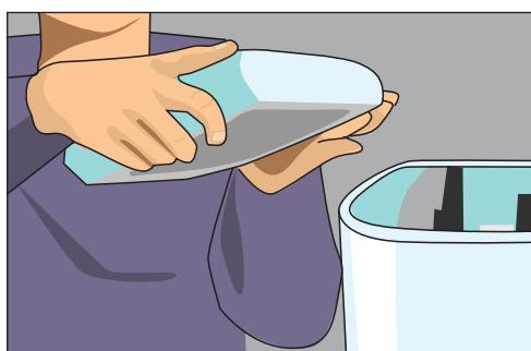
**Рис. 11.65.** Снимаем крышку бачка обеими руками
