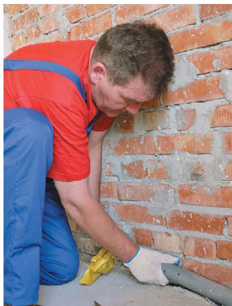
Рис. 8.22. Проверка стыков труб на герметичность
