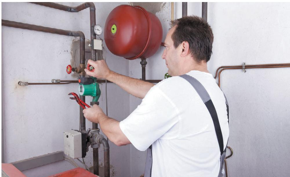
**Рис. 12.21.** Расширительный бак (красного цвета) предотвращает разрыв труб или котла
