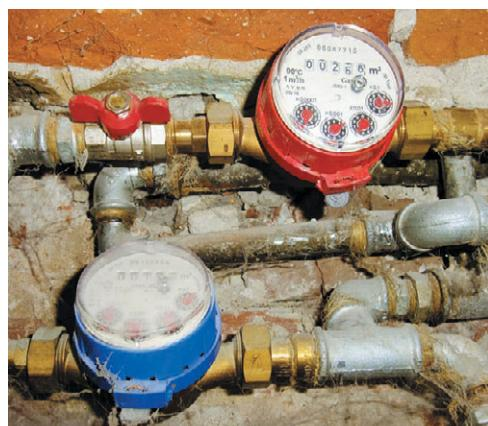
Рис. 6.1. Счетчики горячего и холодного водоснабжения
