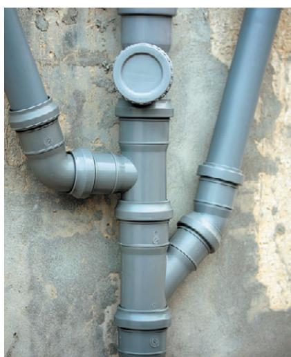
Рис. 8.1. Канализационные трубы в современном доме
