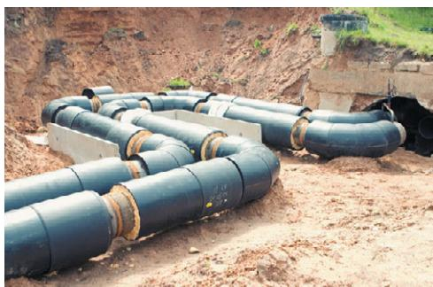
**Рис. 5.5.** Трубы с утеплительным слоем из минеральной ваты
