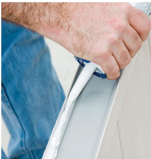
Рис. 1.35. Нанесение силиконового герметика
