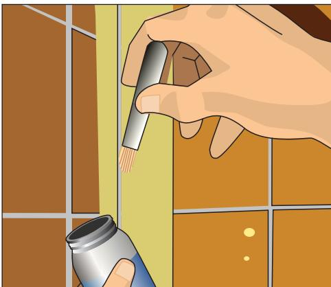
**Рис. 1.43.** Обрабатываем пористый край плитки праймером
