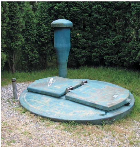
Рис. 8.31. Фильтрационный колодец
