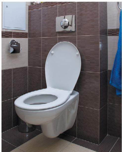
Рис. 10.122. На стене от бачка остается лишь декоративная клавиша для смыывания воды
