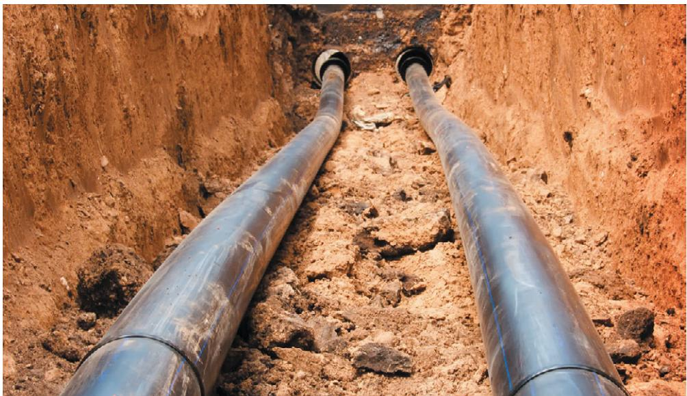
Рис. 5.1. Прокладка водопровода из пластиковых труб
