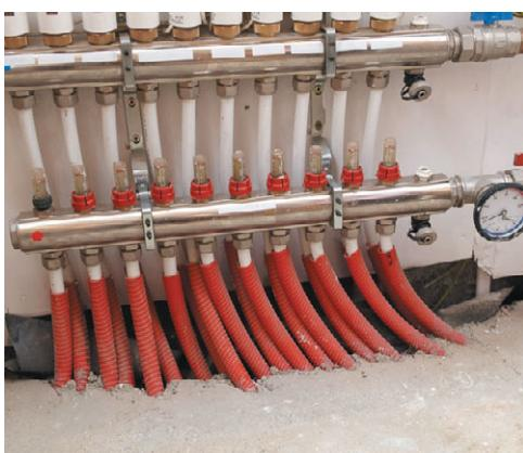
Рис. 12.11. Готовая стяжка и распределительная система пола
