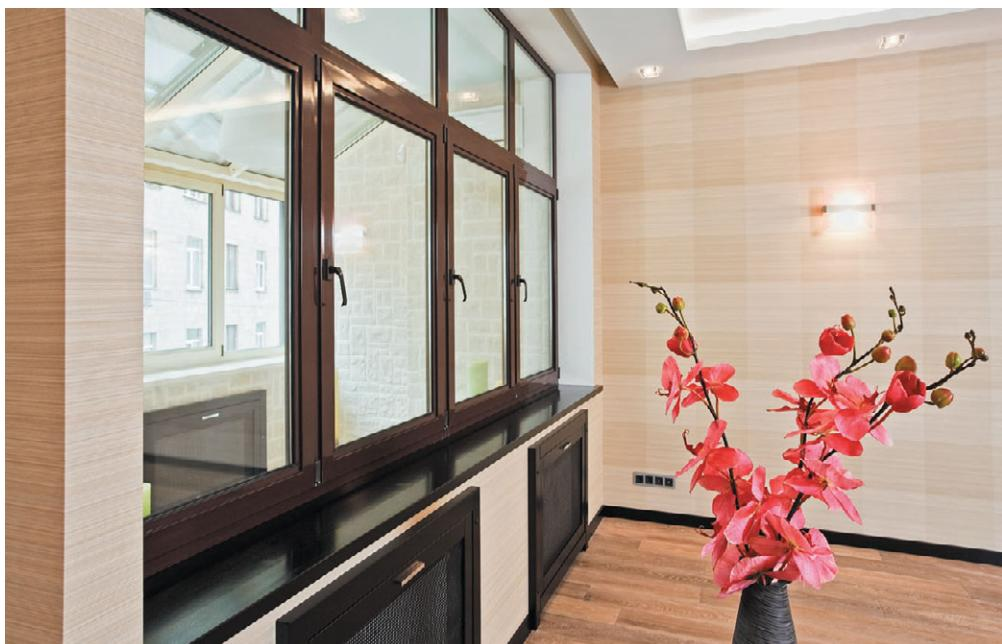
**Рис. 12.49.** Наличие экрана на радиаторе влияет на теплопроводность
