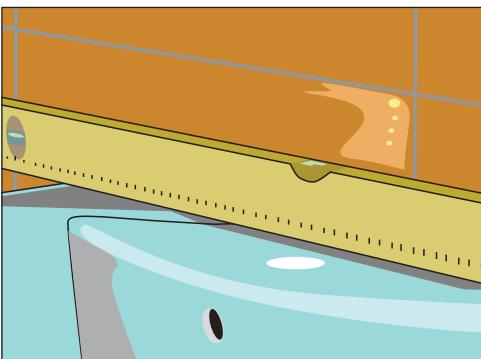
Рис. 10.64. Выравниваем положение умывальника с помощью уровня
