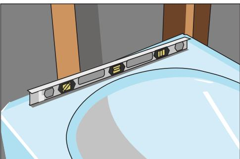
Рис. 10.182. Проверяем положение ванны с помощью уровня
