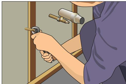
**Рис. 4.36. Закрепляем муфту**
