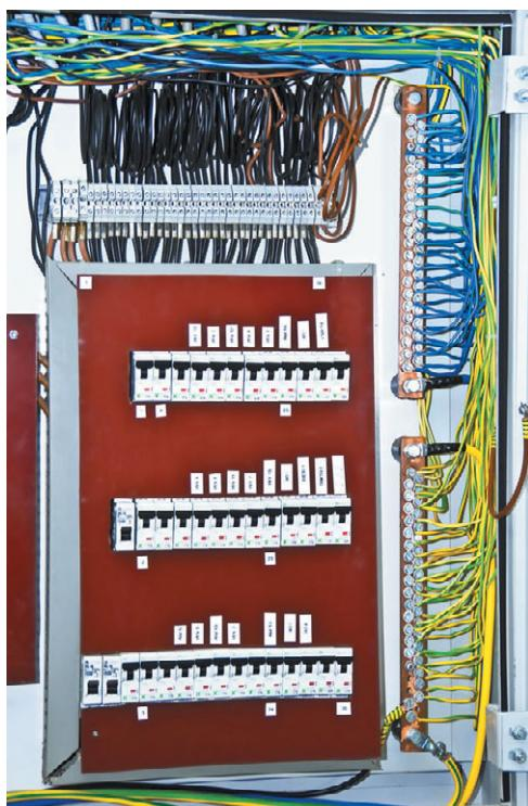
**Рис. 3.5. Устройство защитного отключения монтируют группами на щитке**
