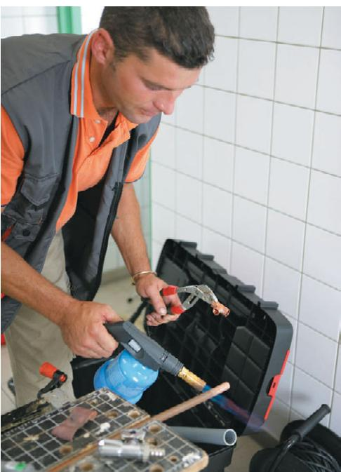
Рис. 4.54. Разогреваем трубу
