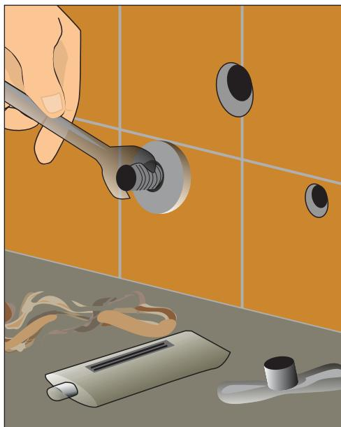
Рис. 10.44. Уплотняем соединение паклей и герметиком (если в будущем предусматривается раскручивание и скручивание угловых вентиляй)
