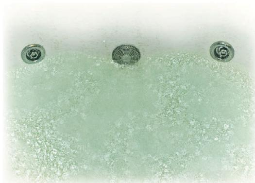
**Рис. 10.195.** Водозаборник (в центре) и гидромассажные форсунки (справа и слева)
