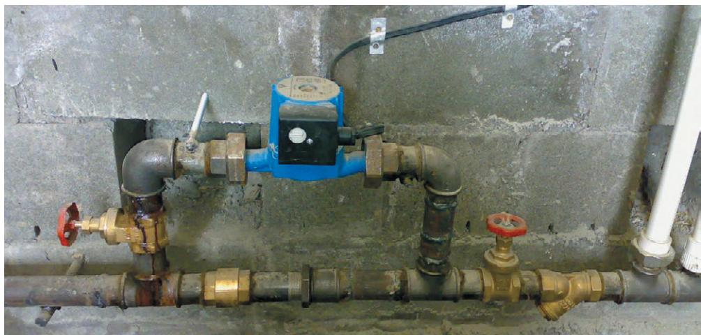
Рис. 2.9. Байпас, установленный в системе отопления
