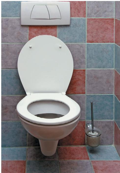
**Рис. 10.94.** Настенный унитаз со встроенным бачком
