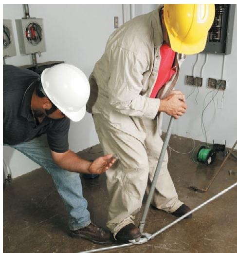
**Рис. 1.11.** Гибка трубы с помощью трубогиба
