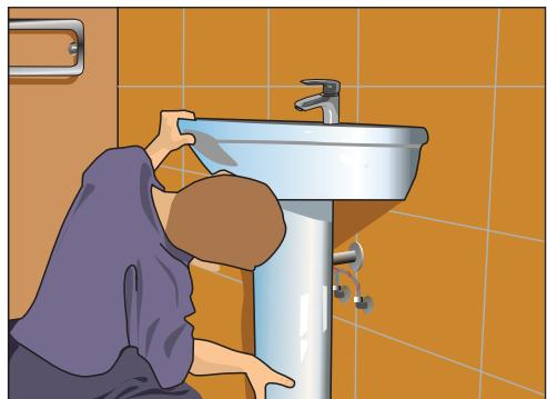
Рис. 10.66. Устанавливаем пьедестал
