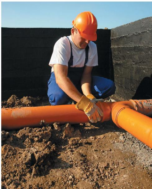
**Рис. 8.2.** Монтаж внутридомовых канализационных труб
