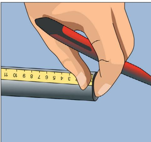
Рис. 4.60. Отмеряем глубину насадки от торца трубы
