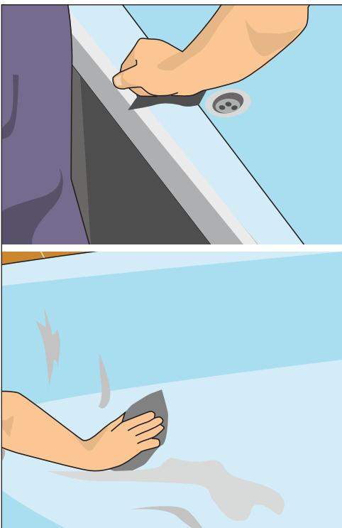
Рис. 11.101. Зачищаем поверхность ванны
