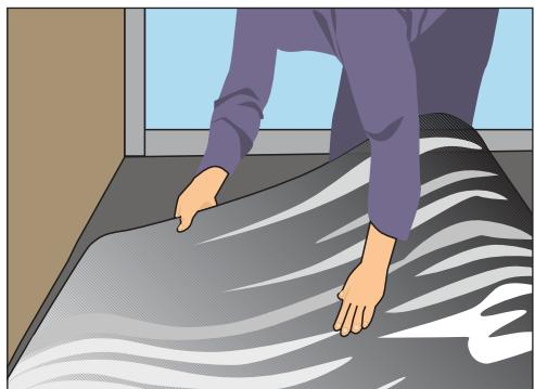
Рис. 12.16. Укладываем вспененный полиэтилен, покрытый алюминиевой фольгой
