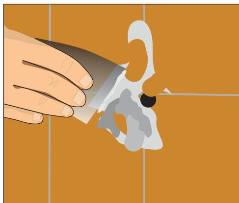
Рис. 10.38. Убираем остатки герметика и разводы
