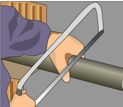
Рис. 8.15. Отпиливаем трубы из ПВХ ножковкой
