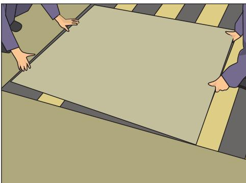
Рис. 12.15. Укладываем плиты из ДСП
