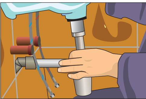
**Рис. 10.9.** Подключаем отводную трубу сифона к канализационной системе
