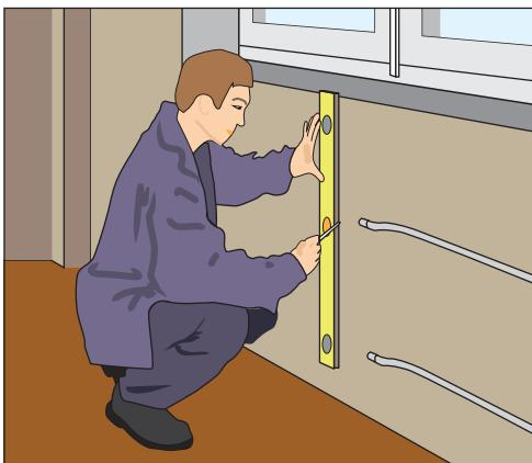
Рис. 12.53. Проводим центральную вертикальную линию крепления радиатора
