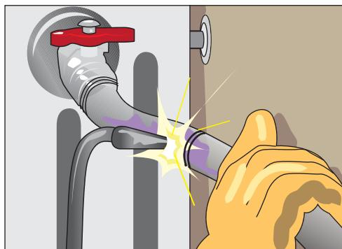
**Рис. 12.65.** Для сваривания труб используем метод газовой сварки
