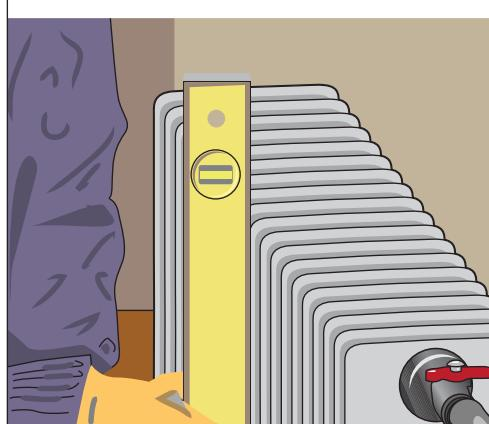
Рис. 12.60. Положение закрепленного радиатора проверяем с помощью уровня
