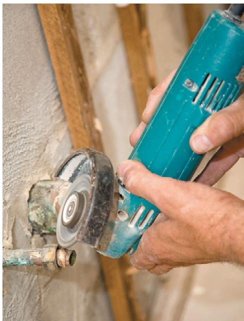
**Рис. 1.15.** Резка трубы с помощью болгарки
