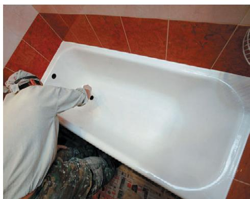
Рис. 11.89. Реставрация старой ванны с помощью эмали
