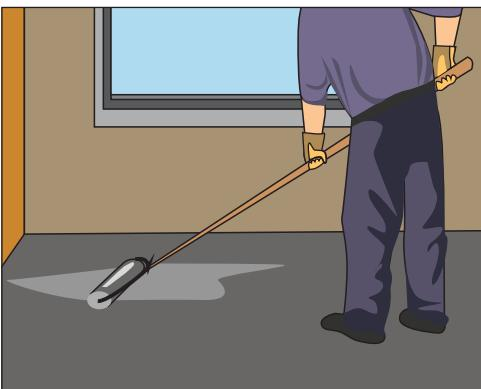
Рис. 12.4. Грунтование бетонного основания
