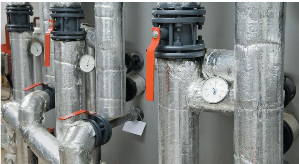
**Рис. 12.41.** Система трубопровода для минимизации теплопотерь изолирована минеральной ватой, сверху — фольгой
