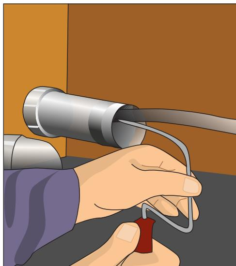
**Рис. 11.25.** Прочищаем трубу с помощью прочистной спирале, аккуратно проталкивая ее вперед вращательными движениями
