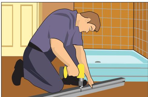
**Рис. 10.217.** Сверлим отверстия в профилях для крепления
