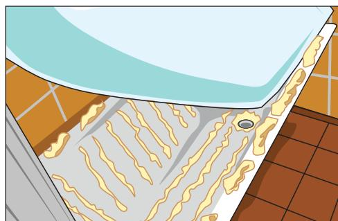
Рис. 11.96. Сажаем акриловый вкладыш на двухкомпонентную монтажную пену
