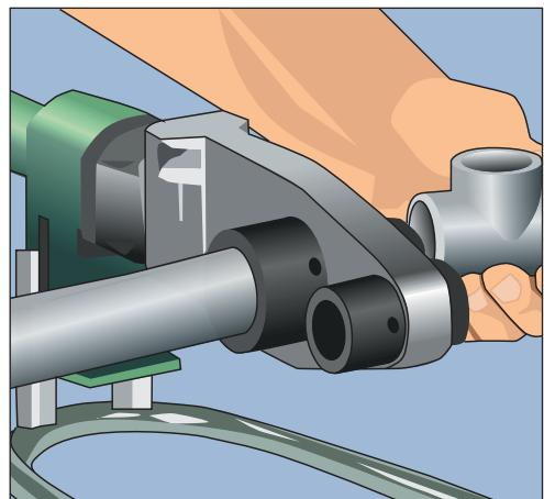
Рис. 4.61. Вставляем элементы пластикового водопровода в сварочный аппарат
