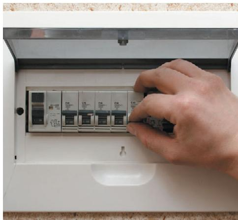
**Рис. 10.274.** Отключение щитка перед началом соединения
