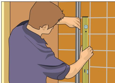
**Рис. 10.219.** Проверяем крепление профилей с помощью уровня
