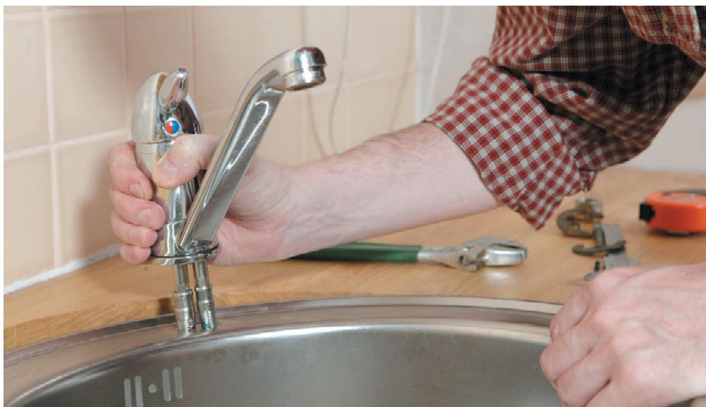
**Рис. 10.14.** Демонтаж старого смесителя на узкой основе
