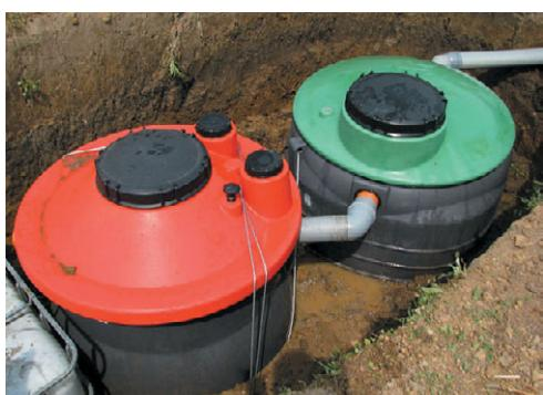
**Рис. 8.25.** Септик заводского производства из полиэтилена
