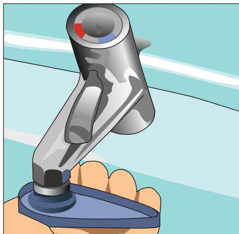
Рис. 11.44. Разбираем рассекатель специальным ключом
