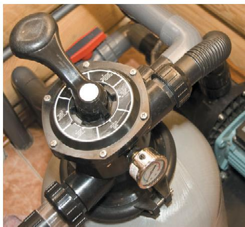
Рис. 7.8. Напольная фильтровальная установка
