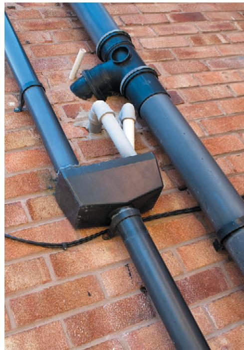
**Рис. 5.4.** Проложенные трубы с заделанными вокруг них пустотами
