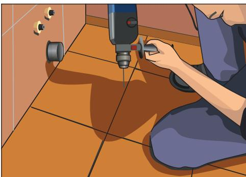
Рис. 10.148. Сверлим отверстия в полу, предварительно разметив места крепления
