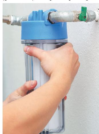
**Рис. 7.4.** Фильтр тонкой очистки
