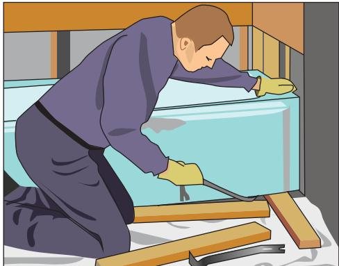
Рис. 10.162. Снимаем ванну
