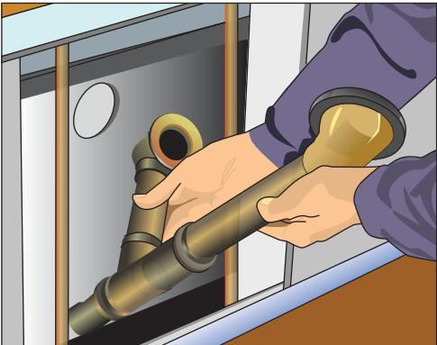
Рис. 10.160. Вынимаем из-под ванны сифон и слив-перелив
