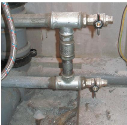
Рис. 12.73. Байпас для полотенцесушителя из трубы из нержавеющей стали на двух тройниках
