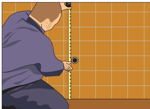
**Рис. 10.126.** Отмеряя высоту, на которой будет расположен писсуар
