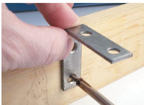
**Рис. 1.50.** Закрепление металлического уголка
