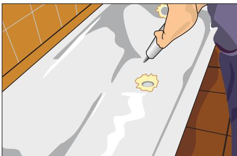
Рис. 11.95. Наносим силиконовый герметик
