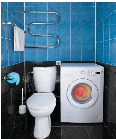
**Рис. 10.234.** Расстояние до канализационных стоков от стиральной машины — не более 1,5 м
