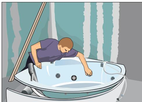
**Рис. 10.190.** Установка джакузи с декоративным экраном
