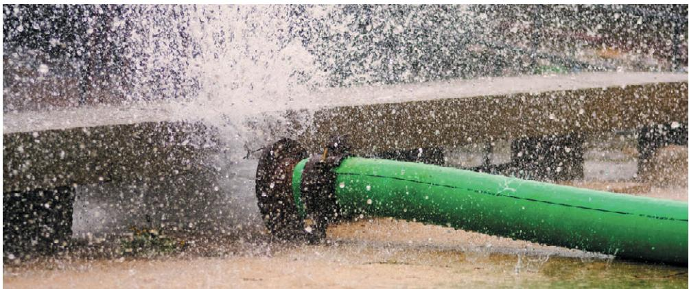
**Рис. 2.5. Прорыв водопровода**
