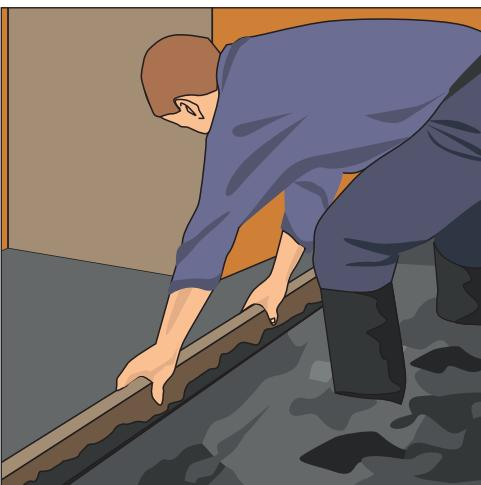
Рис. 12.5. Выравнивание стяжки правилом
