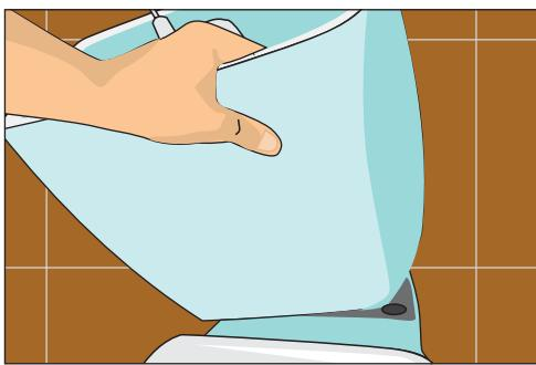
Рис. 11.72. Снимаем бачок
