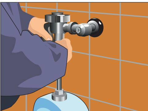
Рис. 10.137. Подключаем писсуар к водопроводу
