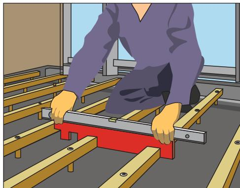
**Рис. 12.13.** Укладываем лаги
