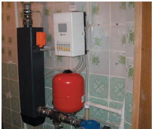
Рис. 12.23. Электрокотел «Сатурн» в системе отопления
