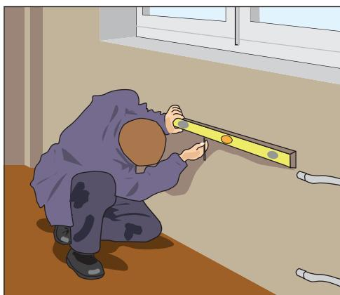
Рис. 12.54. Проводим горизонтальную линию крепления радиатора
