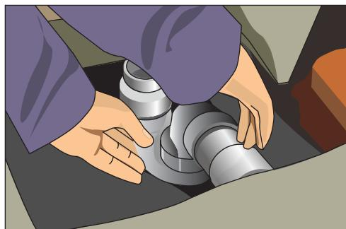
Рис. 10.179. Собираем и прикручиваем сифон
