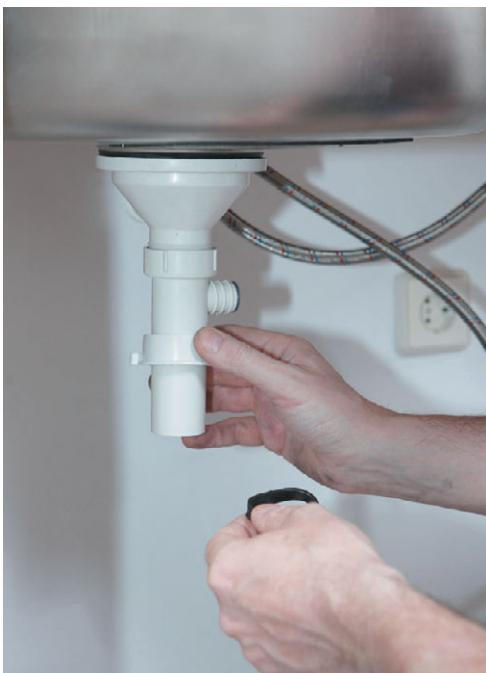
Рис. 10.76. Надеваем уплотнительное кольцо
