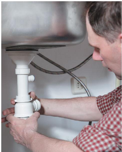
Рис. 10.77. Плотно прижав стакан к трубе, закручиваем гайку
