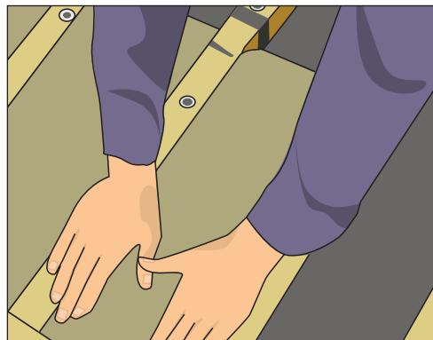
**Рис. 12.14.** Заполняем пространство между лагами теплоизоляционным материалом
