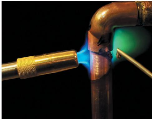
**Рис. 4.52.** Капиллярная пайка медных труб
